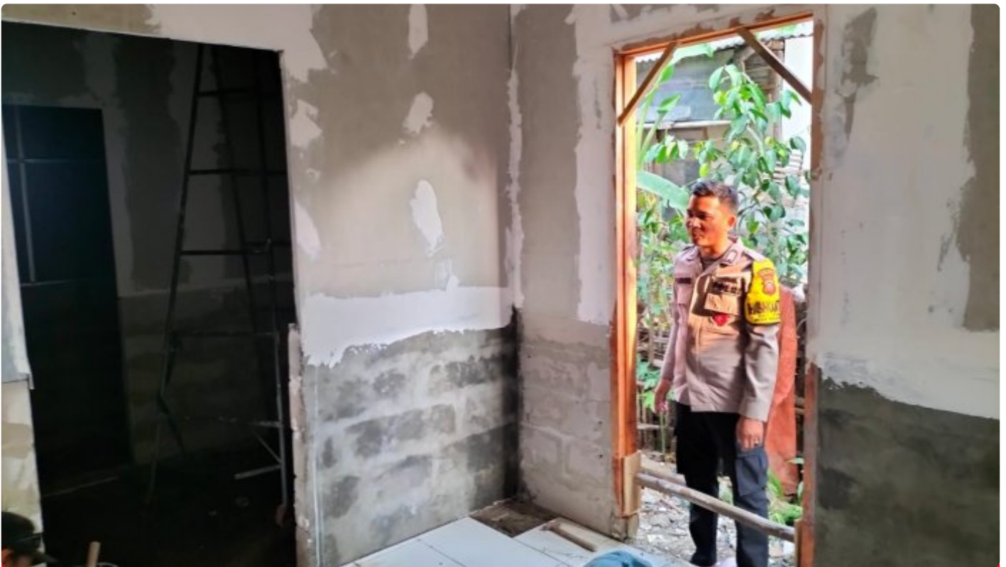
Pembangunan Rutilahu di Kecamatan Terisi Terus Berjalan Lancar
